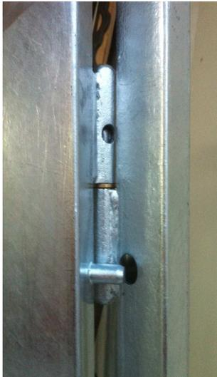
4 \* Aushebelschutz zwischen den Bändern
